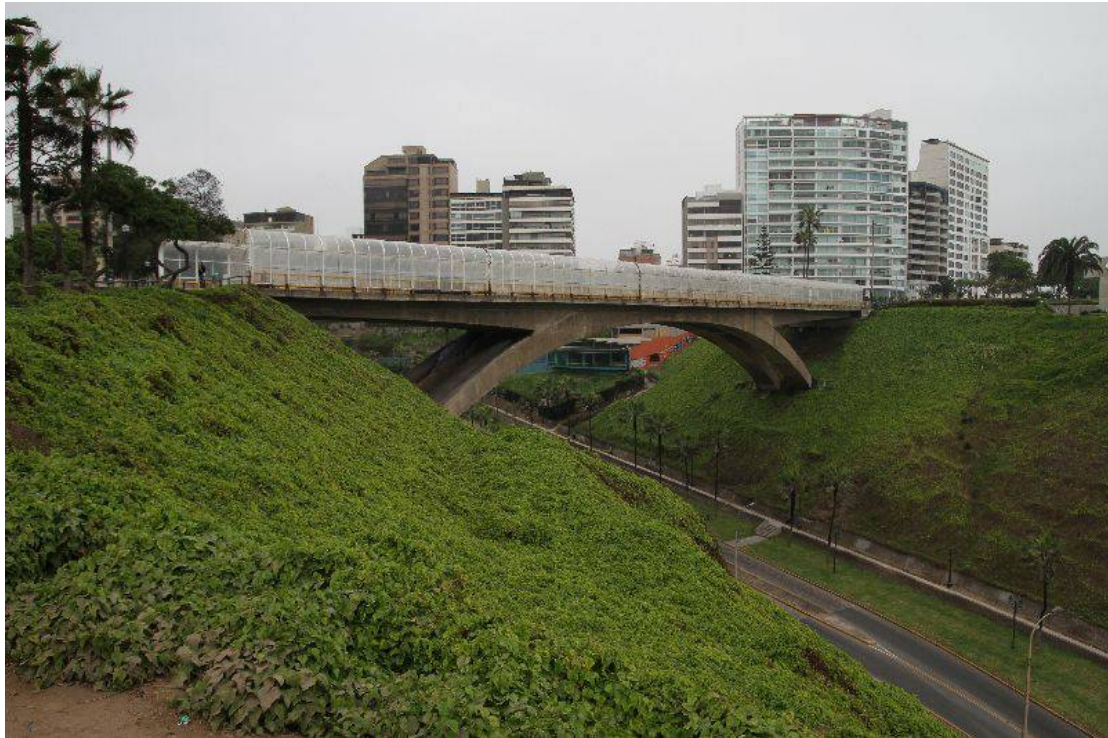
Jalankulkijoiden ja pyöräilijöiden ylikulkusilta.
