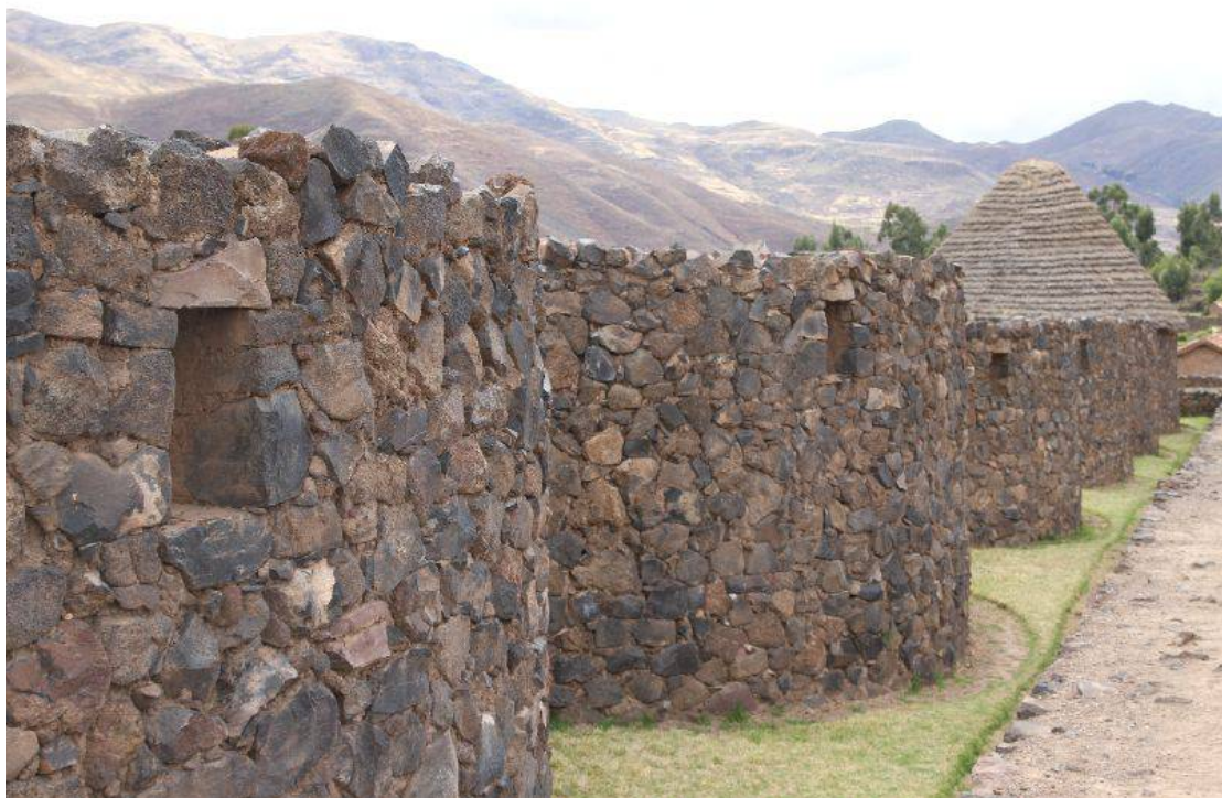
Raunio alueen rakennuksia. Kuvassa ruokavarastoja. Aikoinaan Wiracochan temppelialueelle tuotiin tuotteita rannikkoseudulta ja vuoristosta, molemmilta alueilta oli tänne suurin piirtein sama matka. Wiracocha on inkamytologian pääjumala, kaiken luoja.
